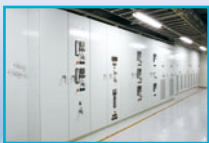
6.6kV Switchgear
