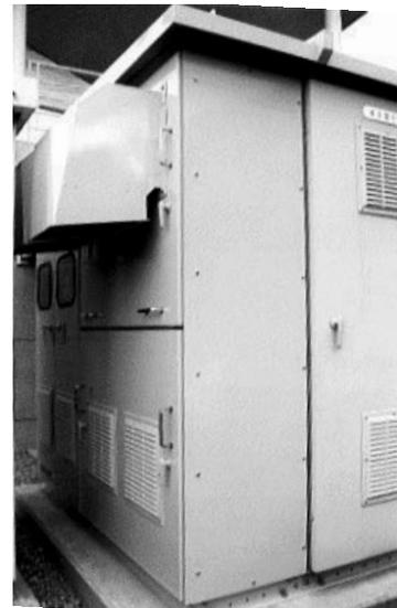
図4 系統連系保護機能付き電圧変動補償装置
