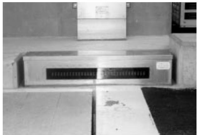
図9 車軸センサ（計量棟入口用）
