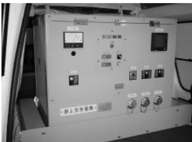
図2 車載形無停電工用インバータ電源外観
