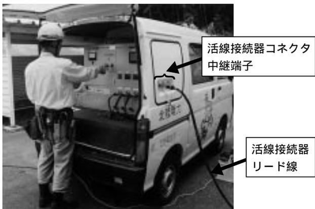
図4 インバータ操作風景と活線接続器コネクタ接続状況
