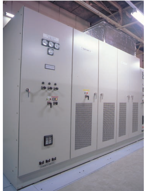
瞬低対策用高速限流遮断装置 (本文30ページ)
