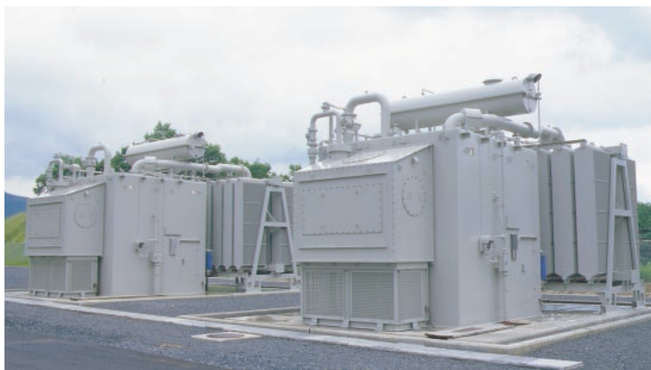
分路リアクトル 60kV 100MVA (本文15ページ)
