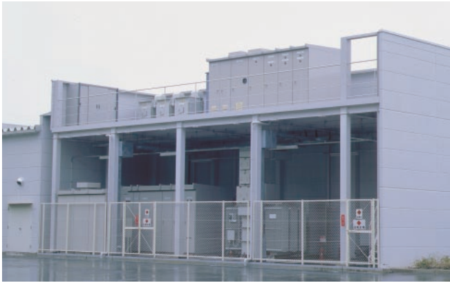
33kV 受変電設備 (本文30ページ)
