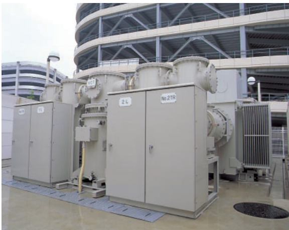
77kV 受変電設備 (本文33ページ)
