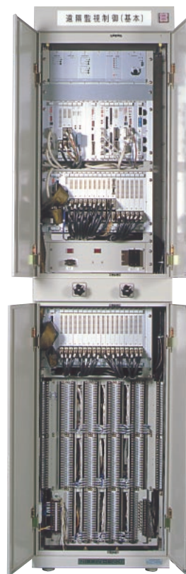
遠隔監視制御装置
