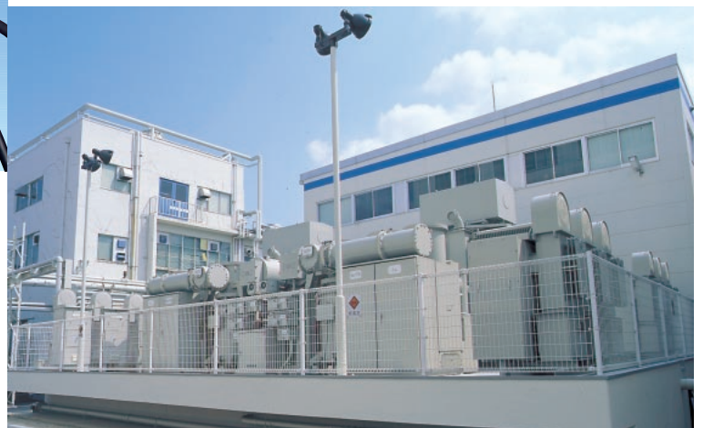
77kV 受変電設備 (本文29ページ)
