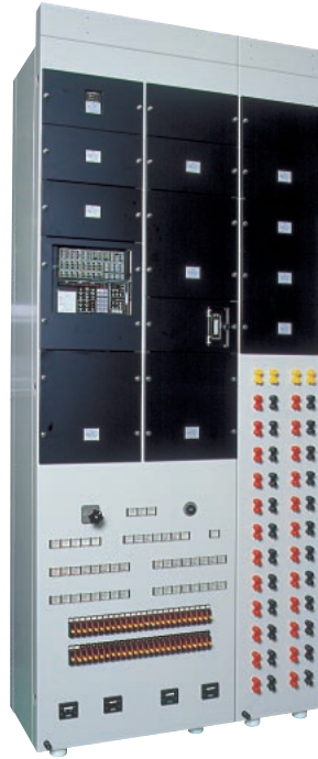
デジタル形調相設備自動制御装置 (本文24ページ)
