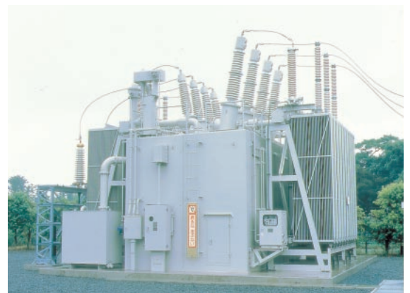
油入変圧器 三相 60Hz 110/66/22kV 60/60/12MVA(本文15ページ)
