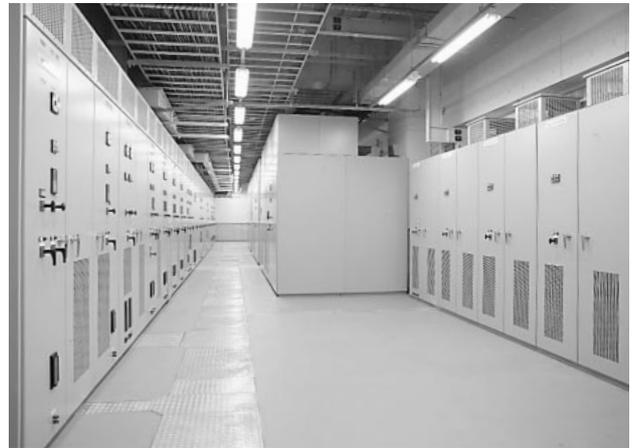
図3 33 kV スポットネットワーク受変電設備
