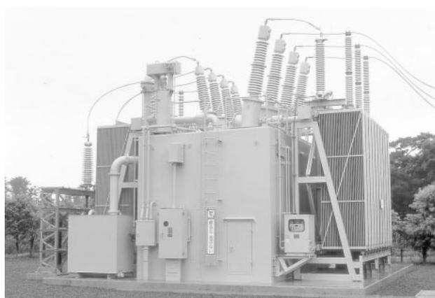
図3 油入変圧器 三相 60 Hz 110/66/22 kV 60/60/12 MVA
