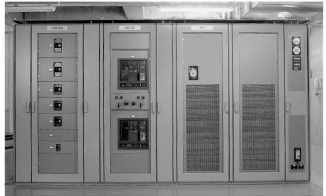
図 14 所内キュービクル（関西電力㈱殿 上二変電所）
