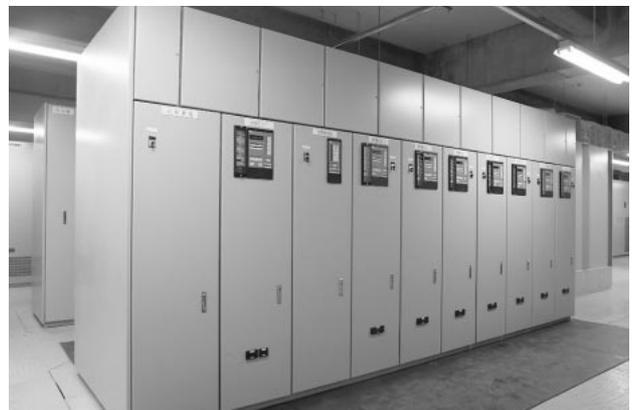
図4 7.2 kV ガス絶縁スイッチギヤ
