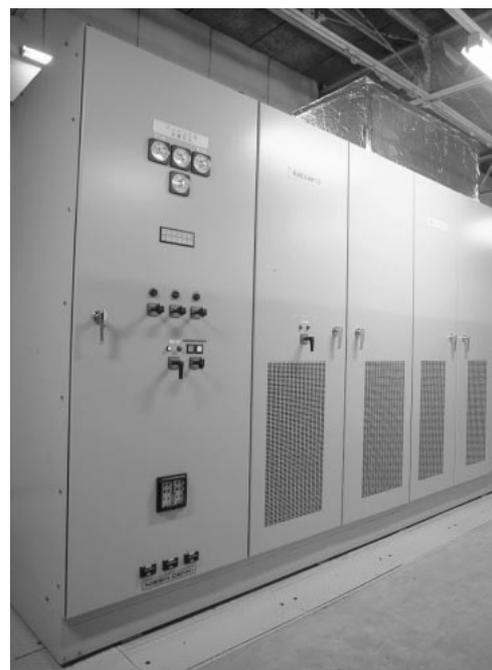
図7 瞬低対策用高速限流遮断装置
