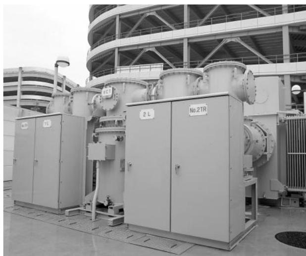
図1 77 kV 受変電設備
