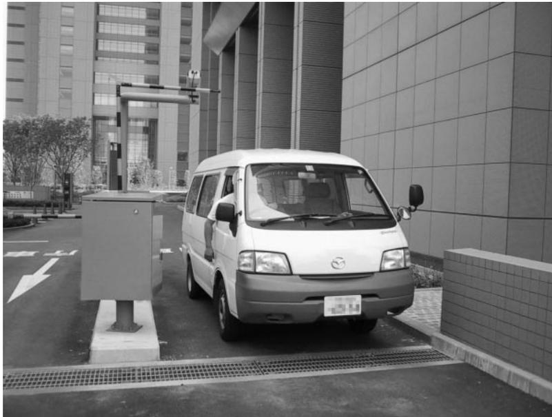
図9 車両ナンバ読取装置設置例(さいたま新都心合同庁舎 1号館)
