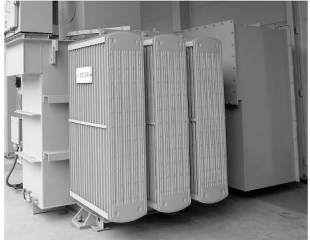
図6 主変圧器 4,500 kVA（凸版印刷(株)殿 播磨工場）
