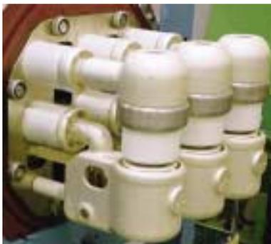
図4 AE形GCB遮断部
