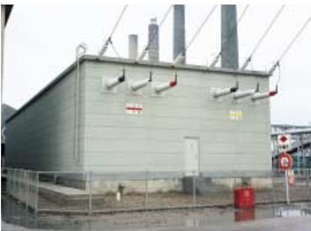
図2 ALCキュービクル式変電所
