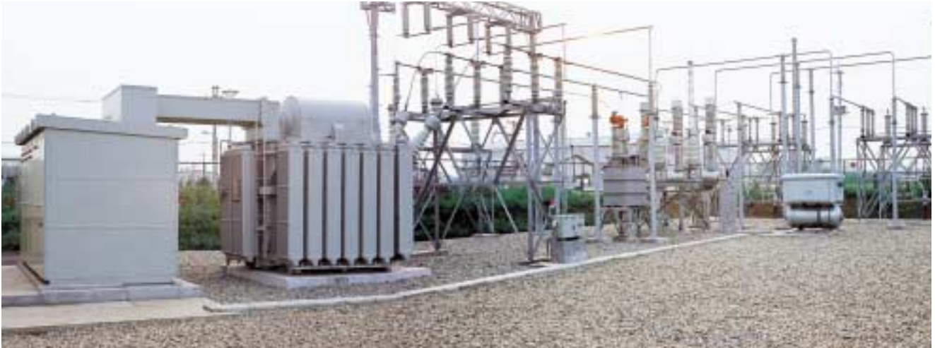
図1 屋外開放形変電所
