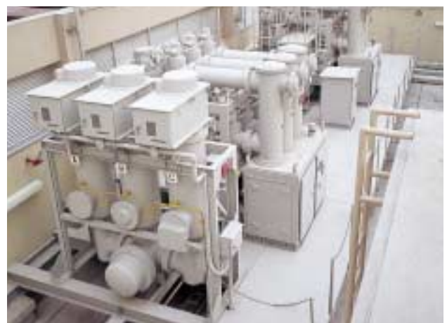
図3 相分離形GIS変電所
