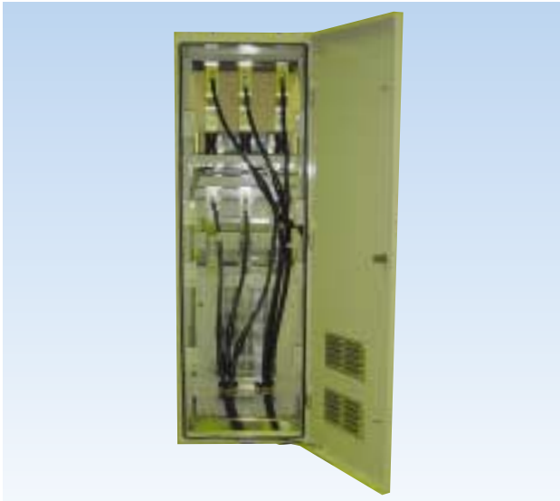
図3 ケーブル接続状況
