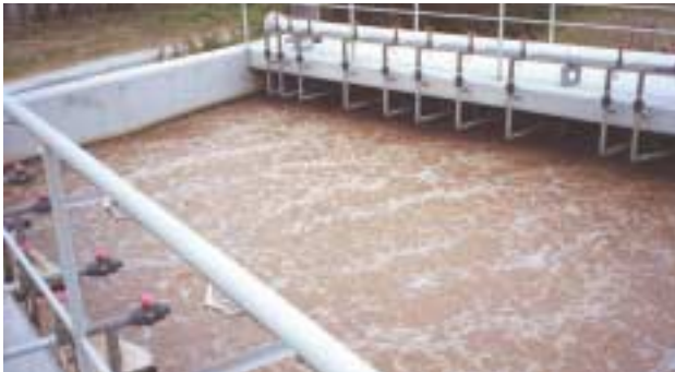
図1 接触曝気槽(活性汚泥法+生物膜法)
