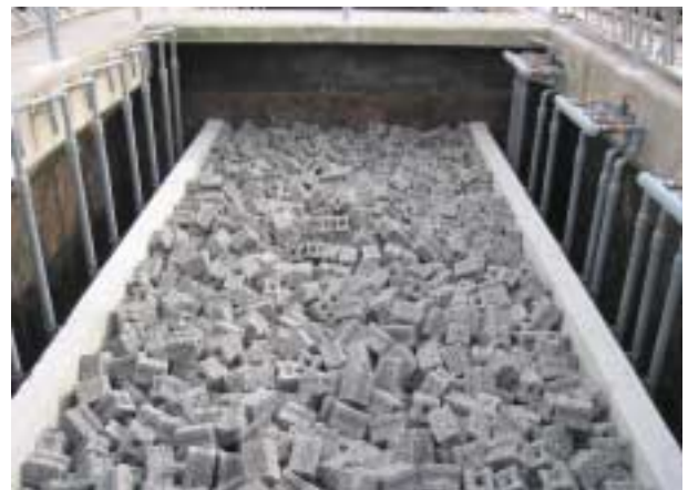
図10 「ハイキュー」充填状態(工事中)
