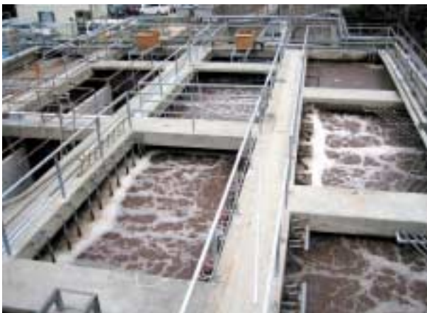
図9 〇県 排水処理プラント外観(工事中)
