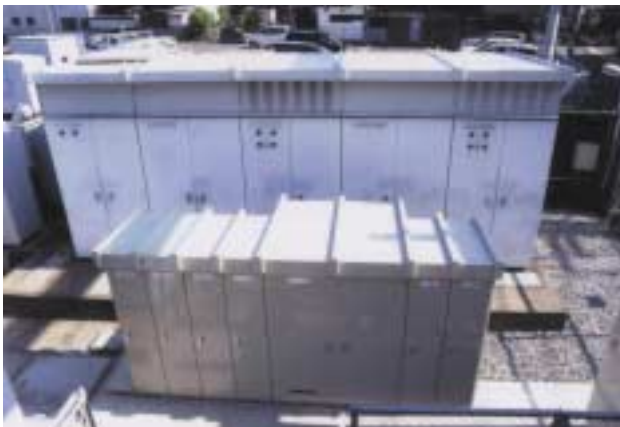
図12 当社本社工場受変電設備 (写真奥が既設24kV気中配電盤) (写真手前がXAE2G)
