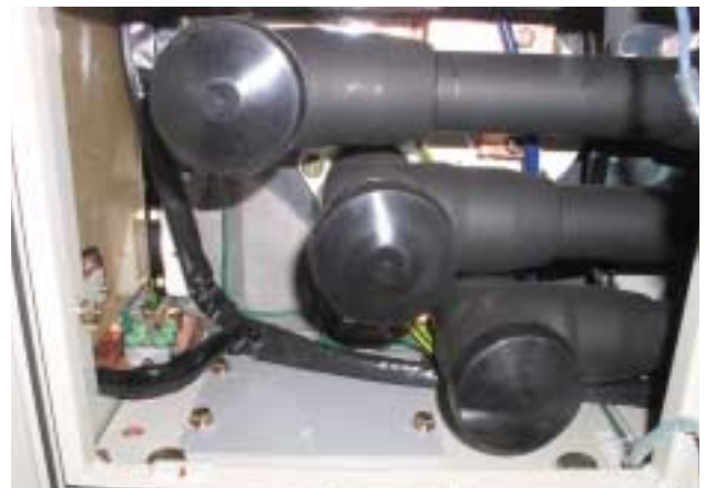
図7 固体絶縁母線取り付け状況
