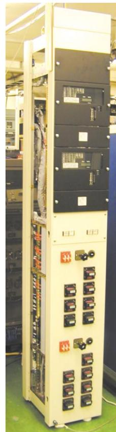
図6 デジタル形SC保護継電装置
