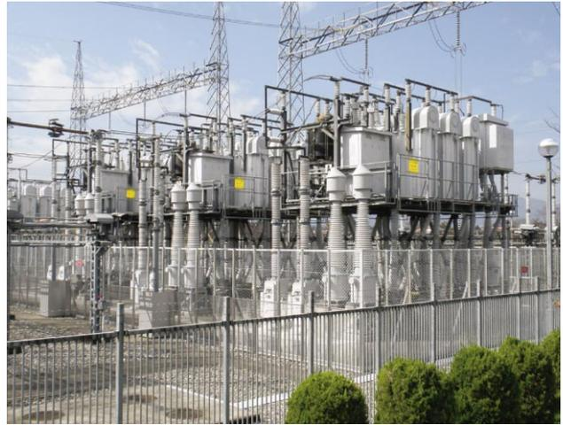
図2 関西電力株式会社 城端開閉所 直列コンデンサ設備
