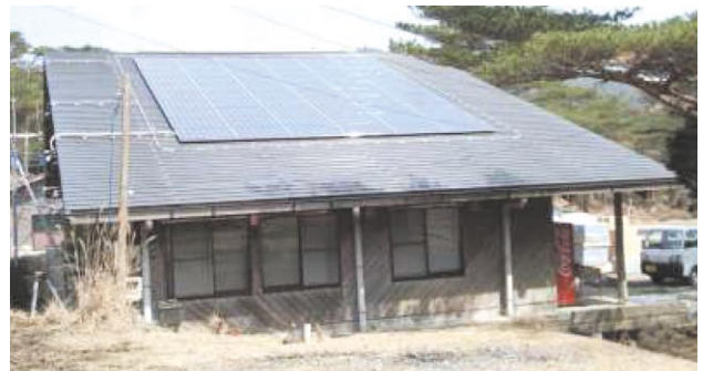
図10 太陽電池10.5kW 設置状況
