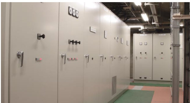
図1 高低圧スイッチギヤ 200821
