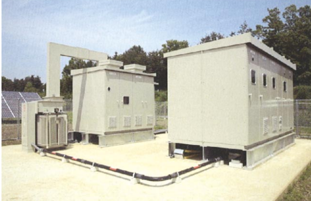
図8 6.6kVスイッチギヤ 20089
