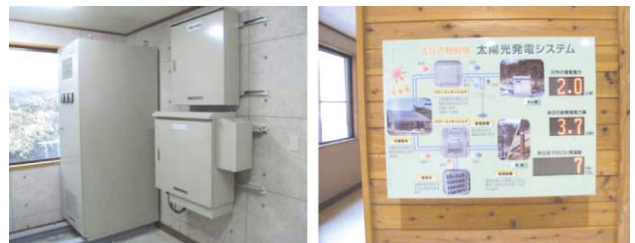
図11 パワーコンディショナ及び表示装置設置状況
