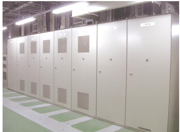
図3 高低圧スイッチギヤ
