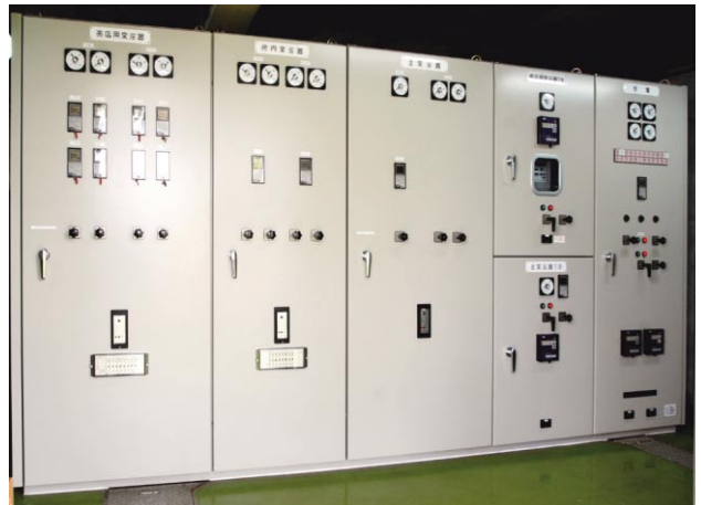
図6 6.6kV高圧受配電設備
