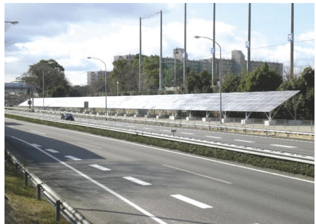
図4 太陽電池全景（太陽電池560枚幅5m×長さ145m）
