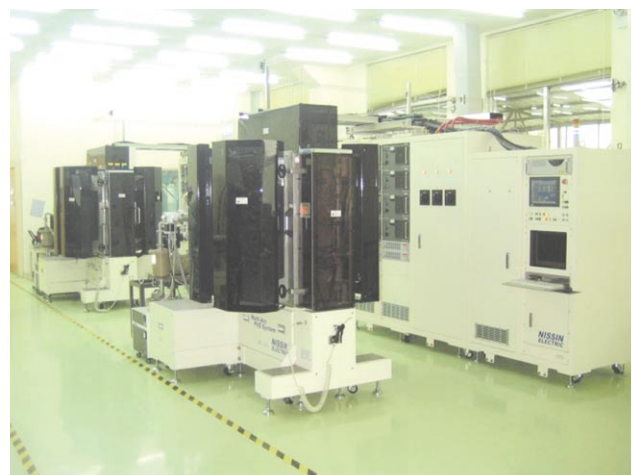
図4 M500設置例 日新高性能塗層（東莞）有限公司
