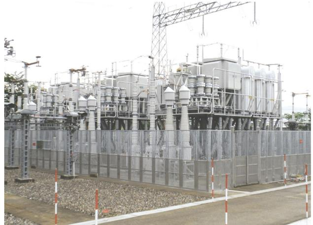
図3 関西電力株式会社殿 城端開閉所 直列コンデンサ設備
