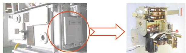
図13 遠制鎖錠装置
