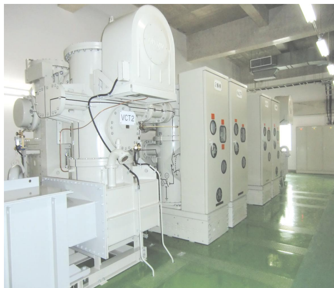
図1 66kV受変電設備（GIS部）
