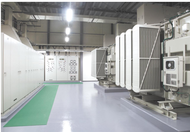
図1 22kV受変電設備(夢洲コンテナターミナル株式会社殿) (24kV縮小形ガス絶縁開閉装置、ガス絶縁式変圧器) 200918
