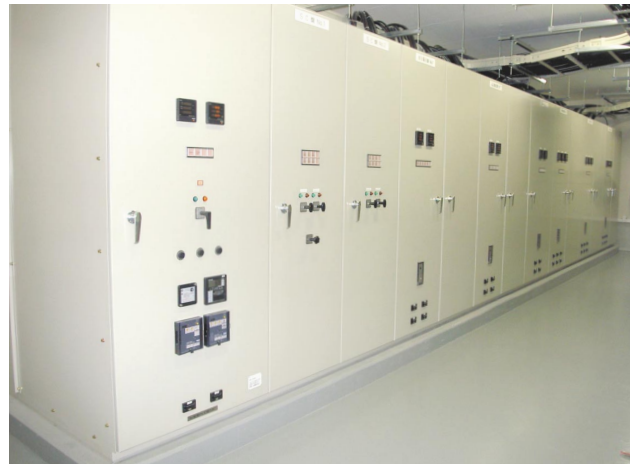
図3 高低圧スイッチギヤ
