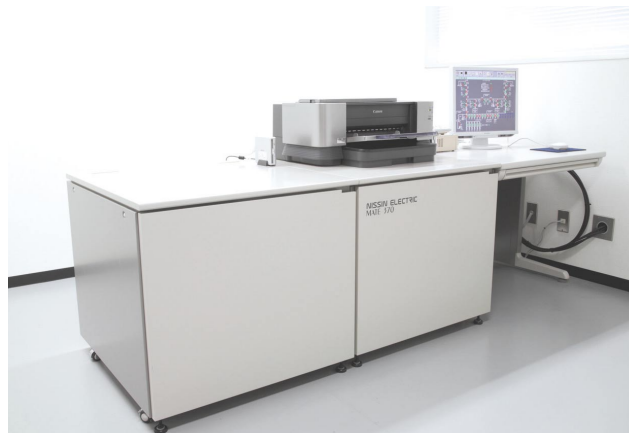
図2 中央監視制御装置
