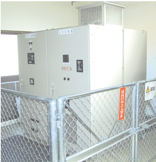
図1 7.2kV縮小形スイッチギヤ
