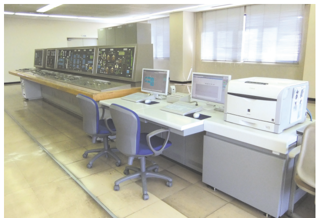
図7 更新後のLCD監視制御装置
