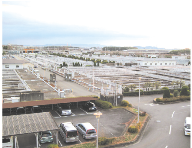
図3 鳥羽水環境保全センター水処理第2課対象施設
