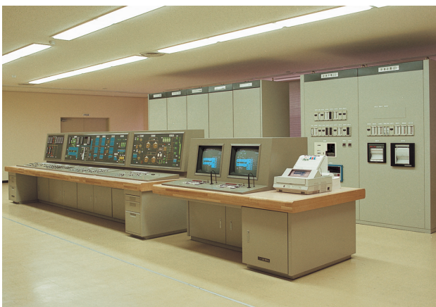
図6 更新前のCRT監視制御装置
