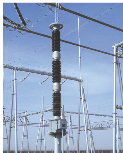
図5 日新電機（無錫）有限公司製CVT
