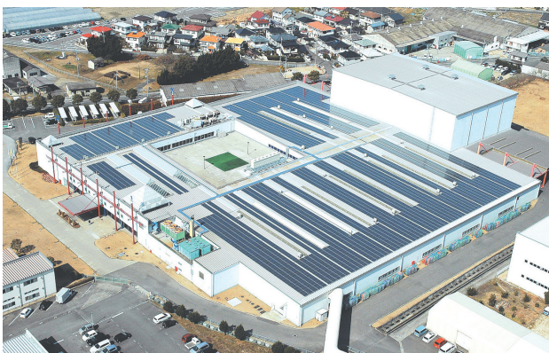
図4 株式会社ベネッセコーポレーション殿 720kW太陽光発電システム全景
