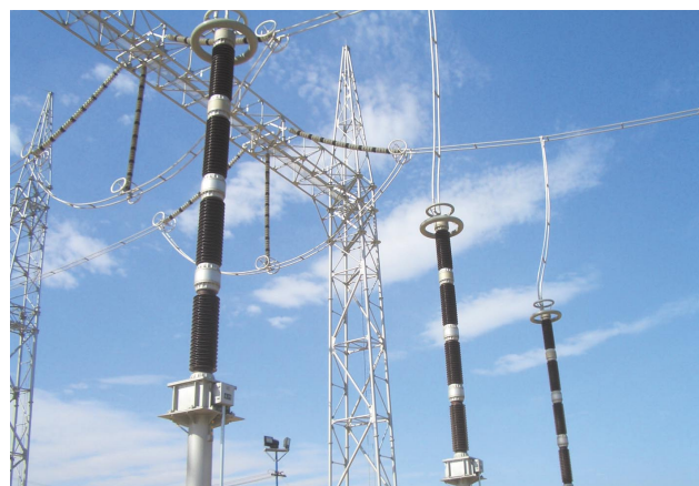
Fig. 26 750 kV CVT
