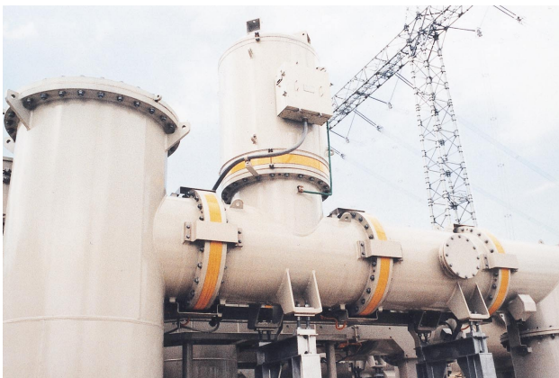
Fig. 18 800 kV Gas VT 2000-77
