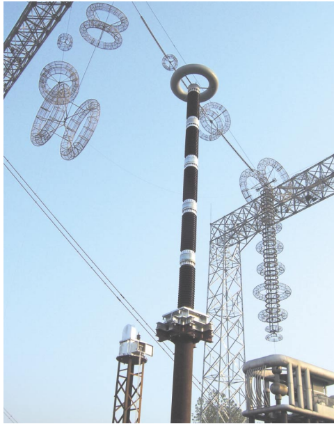
Fig. 27 1,100 kV CVT
