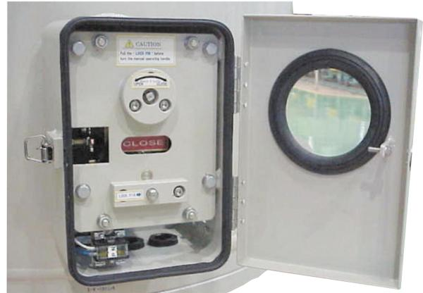
図5 三相ID付きガスVT(絶縁フレーム側面操作方式)手動操作器
