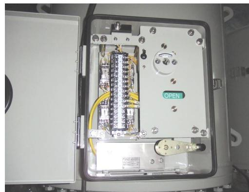
図6 三相ID付きガスVT(絶縁フレーム側面操作方式)電動操作器
