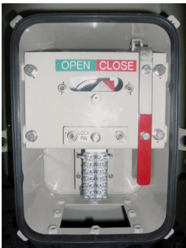
図4 単相ID付きガスVT 手動操作器
