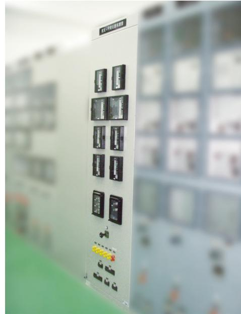
図14 変圧器保護用保護継電器盤 999
