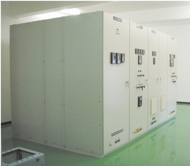
図13 24kVスイッチギヤ 999
