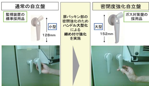
図4 扉ハンドルの締め込みトルク強化方法
