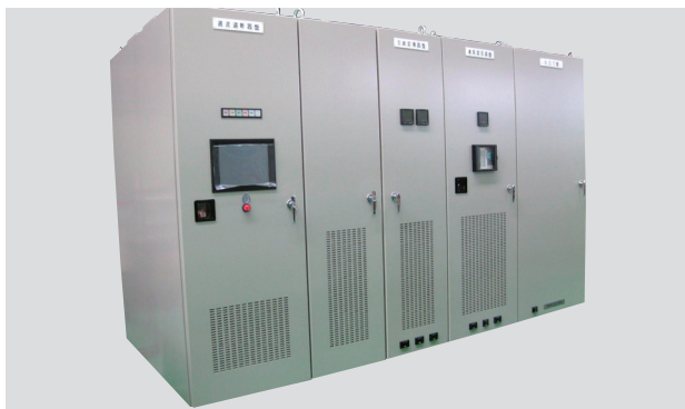
図 4. 2. 1. 2 交直変換装置（外観）
