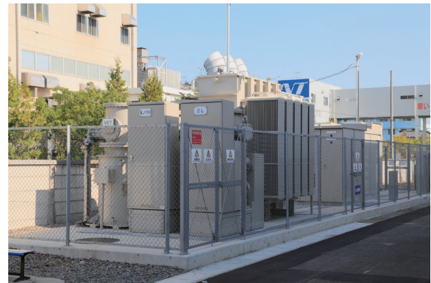
図4 77kV受変電設備
