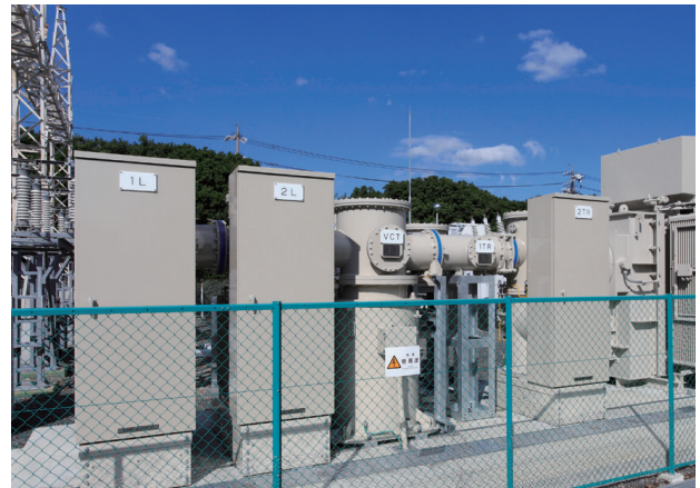
図3 77kV受変電設備
