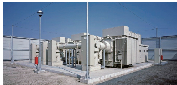
図2 66kV受変電設備
