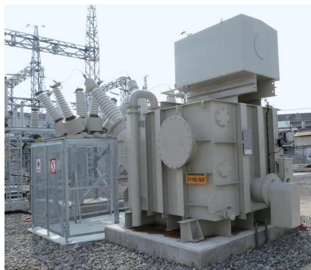
図2 接地変圧器付き中性点リアクトル
