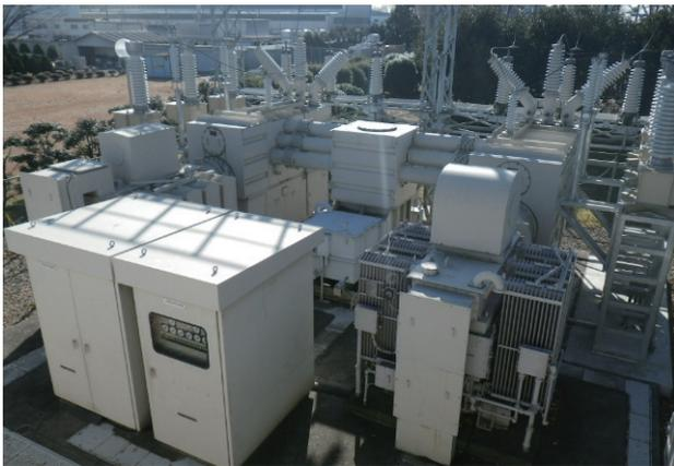
図3.5.1 当社前橋製作所66kV特高受変電設備
