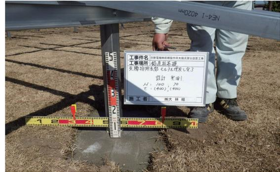
図 3.2.7(b) モルタル打設による引抜強度対策
