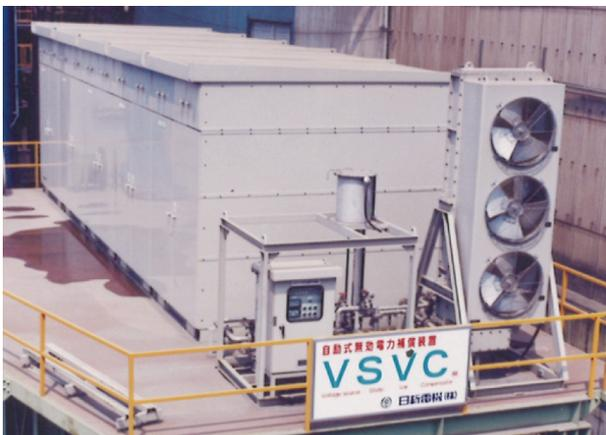
図3 某製鉄所向けV SVCの外観
