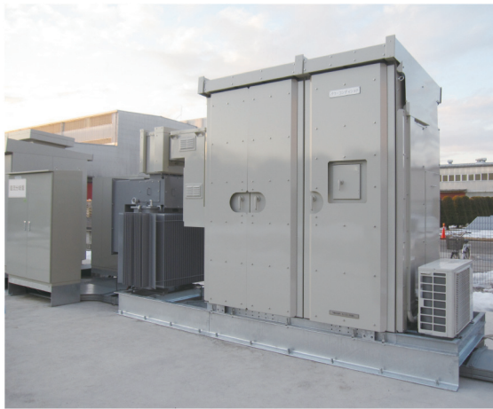
図2 前橋製作所でのフィールド検証
