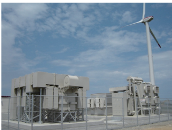
図4 株式会社ユーラスエナジー宗谷殿宗谷岬ウインドファーム納めSVC
