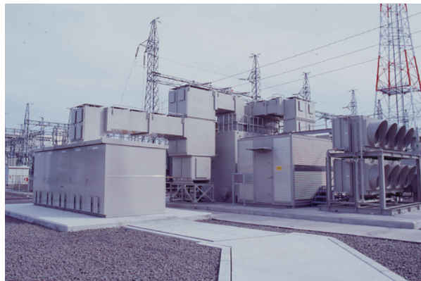
図3 東北電力株式会社殿仙台港変電所納めSVC
