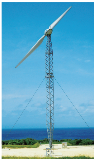
図6 波照間島に設置された可倒式風力発電設備
