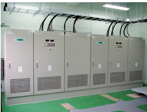
図9 電力変換器盤、フライホイール駆動装置 各2群
