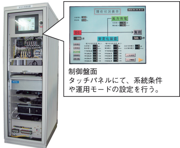
図11 安定化装置制御盤
