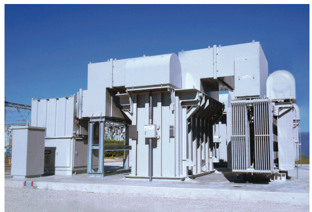
図1 縮小形電力用オールフィルムコンデンサ設備
