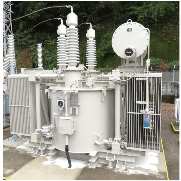
図2 分路リアクトル (66kV 7.5Mvar 70dB)
