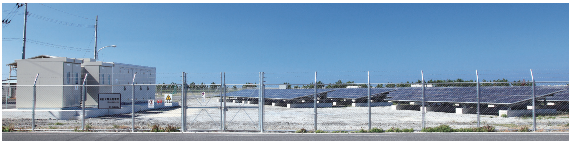
埋立地に設置された太陽電池、PCS（屋外パッケージ）、受変電設備
