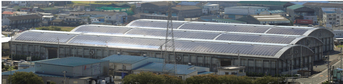
倉庫屋根上に設置された太陽電池
