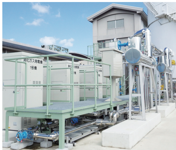
図1 消化ガス発電設備
