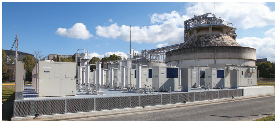
図5 コジェネレーションシステム 201521 16
