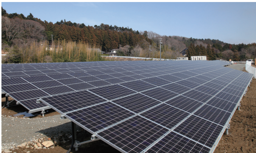
図8 ソーラーパークからはⅡ太陽光発電所 全景
