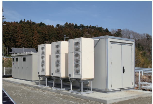
図7 ハイブリッド冷却方式エンクロージャ設置状況 201524③
