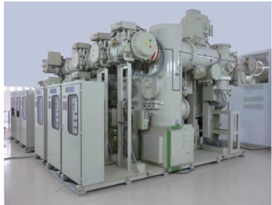
図1 110kV ガス絶縁開閉装置 (GIS)
