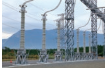
550kV コンデンサ形 計器用変圧器
