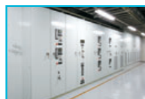
6.6kV Switchgear
