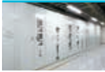
6.6kV Switchgear
