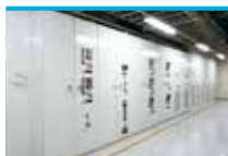
6.6kV Switchgear
