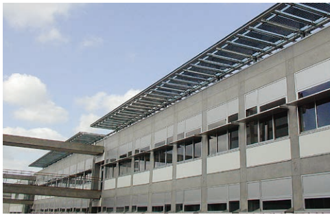
北九州市立大学 国際環境工学部 様 各種分散電源導入 光透過性庇20kW+陸屋根130kW 福岡県
