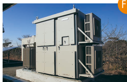
九十九里長谷メガソーラー太陽光発電所 様 500kWパワーコンディショナ オールエアコンタイプ 2MW 千葉県
