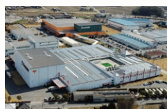
720kW ベネッセコーポレーション
