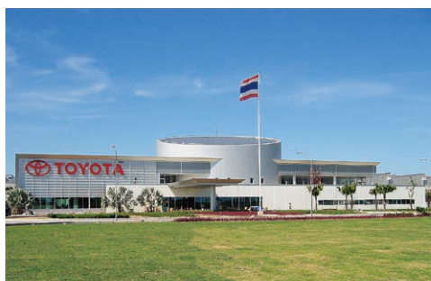
TOYOTA MOTOR THAILAND CO.,LTD 様 タイ国内電力系統への連系システム 50kW タイ
