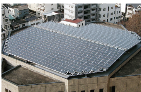
徳島市庁舎 様 屋根全面設置 100kW 徳島県
