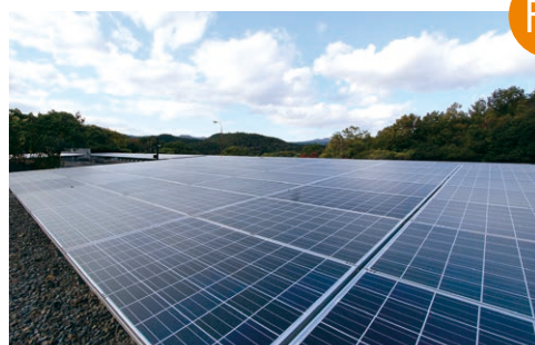
京都市上下水道局 松ヶ崎浄水場 様 フルターンキー施工 (配水池上部に太陽電池設置) 730kW 京都府
