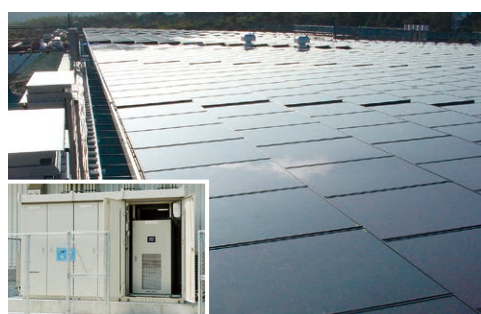
沖縄総合農産加工株式会社 様 出力抑制機能付パワーコンディショナ、 PLC制御盤、計測表示装置納入 230kW 沖縄県
