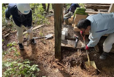
4.展望台の修復作業
