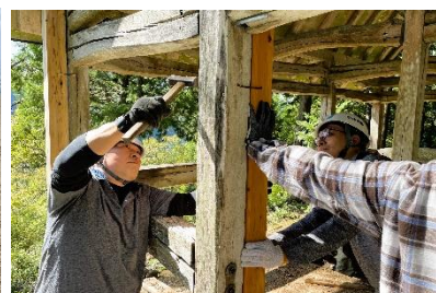
展望台の修復作業(5)
