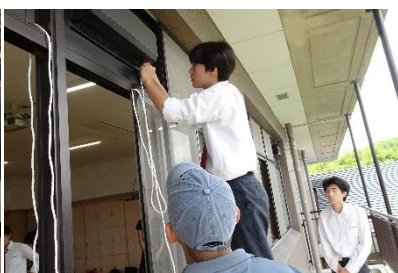
学校に断熱シートを設置(2)
