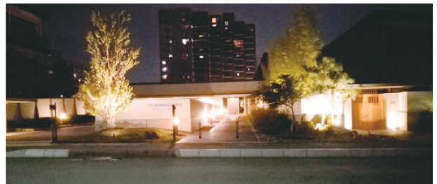
図4 研修センター・嵯峨野荘正面から見た夜間照明（直流配電システムから太陽光余剰電力を給電）
