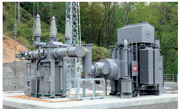
図3 66kV 特高連系変電設備（熊追発電所）
