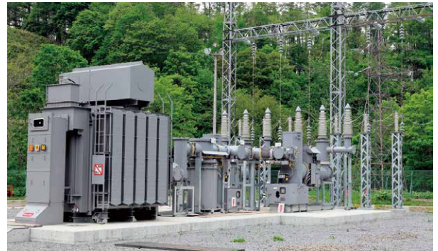
図2 66kV 特高連系変電設備（新桂沢発電所）
