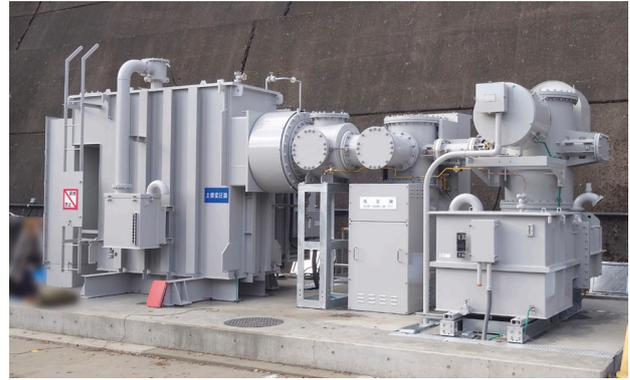
図3 72kV 連系変電設備
