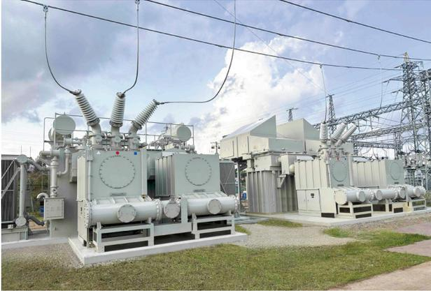
図1 66kV 分路リアクトル (左) および66kV コンデンサ (右)
