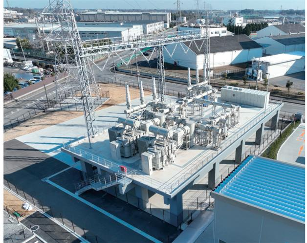
図2 154kV 特高受変電設備（架台上設置）
